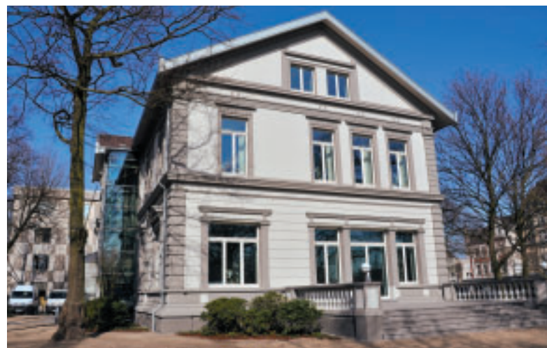
An der denkmalgeschützten Fassade der Duisburger Grillo-Villa führte die Hetzel-Gruppe Stuck- und Putzarbeiten durch. (Foto: Astrid Theisen)
