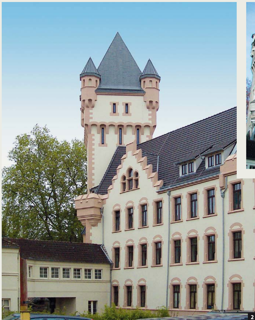
Abb. 2/3: Nach der nach historischem Vorbild durchgeführten Sanierung zeigt sich das Gebäude wieder als prächtiger Blickfang, auch der Turm der Hördter Burg, der als historisch bedeutsam gilt.
